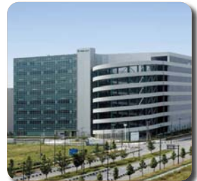
プロロジスパーク大阪2 日本プロロジスリート 投資法人
