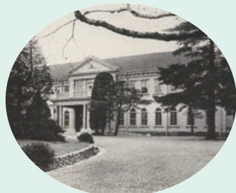
建替前の埼玉県庁舎 (埼玉県立図書館所蔵資料)
